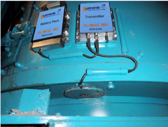
Installation von Sendeeinheit und Wechselakku an der Mischerwandung
